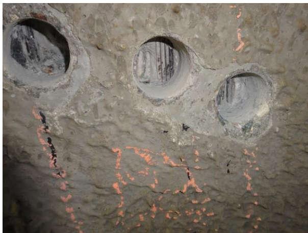
Obr. 3.27: Sonda P2, nosník č. 12 zdola, ve středu rozpětí, odhaleny tři kanálky
