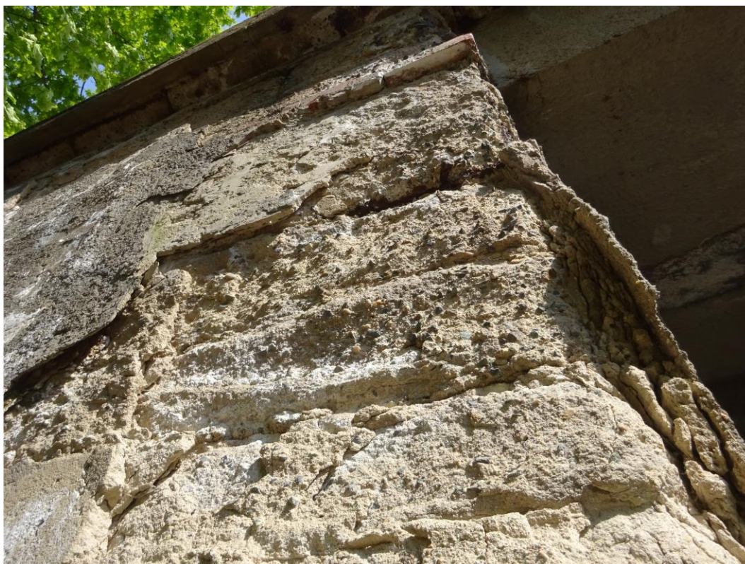
Obr. 1.9: Opěra O1 zprava, omítka opadaná, rozpad povrchové vrstvy betonu
