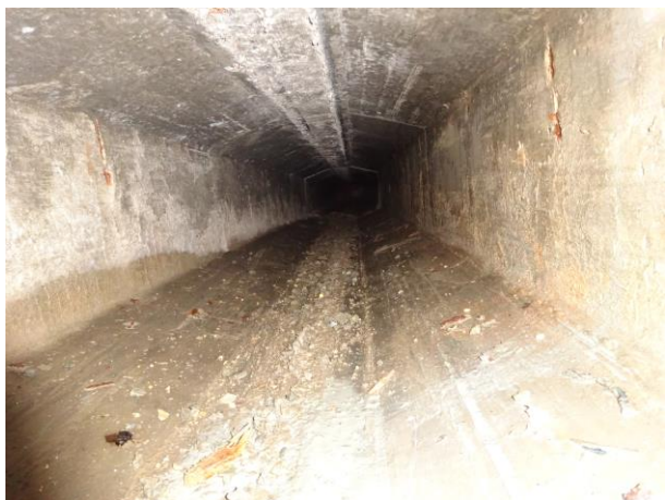
Obr. 3.33: Nosník č. 1, pohled proti směr staničení, foto skrz průvrt V7, vápenné výkvěty ve stěnách a stropu, lokálně odhalená a korodující betonářská výztuž (trmínek ve stěně)
