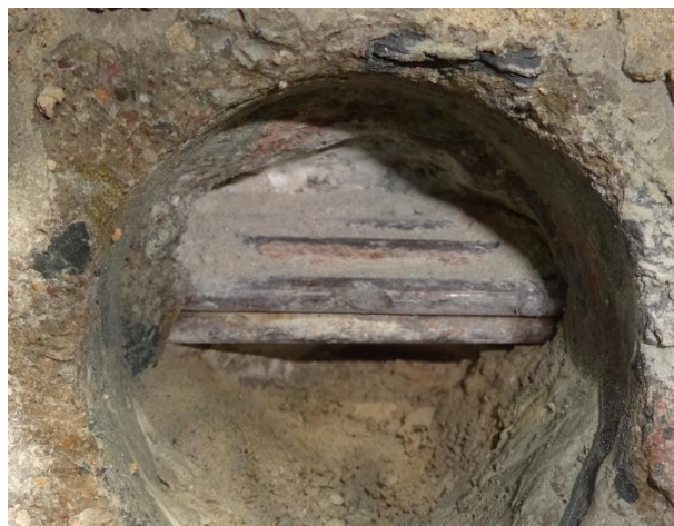
Obr. 3.26: Sonda P1, detail: kanálek zainjektovaný, dráty napadeny mírnou povrchovou korozí, krytí 35 – 37 mm, beton v okolí kanálku nezkarbonatovaný
