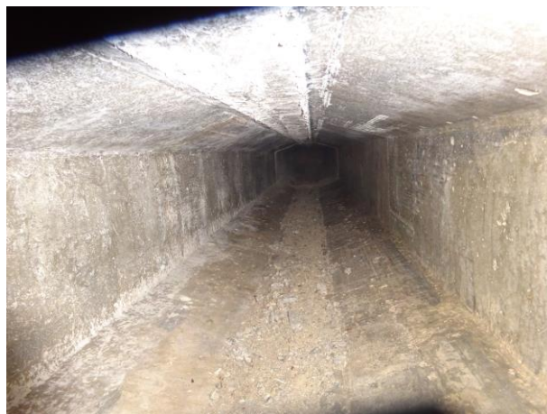
Obr. 3.34: Nosník č. 18, pohled ve směru staničení, foto skrz průvrt V11, stopy po zatékání, vápenné a solné výkvěty, v době prohlídky dutina suchá
