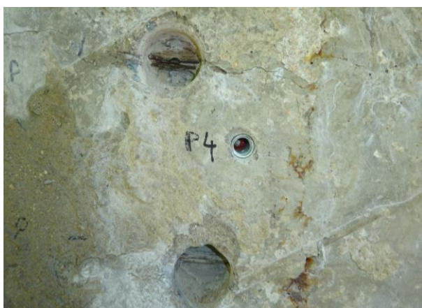
Obr. 3.31: Sonda P4, nosník č. 18 z boku, odhaleny dva kabely ve stěně nosníku, na povrchu nosníku trhliny kopírující průběh předpínací výztuže
