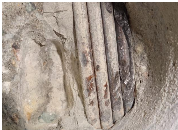
Obr. 3.28: Sonda P2, detail: kanálek zainjektovaný, dráty napadeny mírnou povrchovou korozí, krytí 47 – 50 mm, beton v okolí kanálku nezkarbonatovaný
