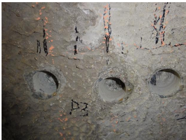
Obr. 3.29: Sonda P3, nosník č. 8 zdola, ve středu rozpětí, odhaleny 3 kanálky, u jednoho z kabelů odhalena i podélná betonářská výztuž – bez koroze
