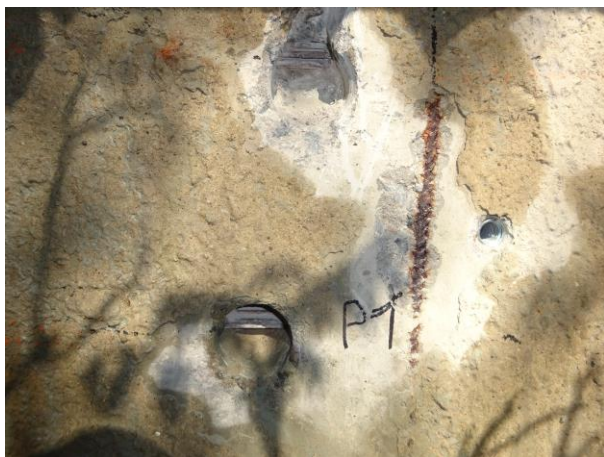
Obr. 3.25: Sonda P1, nosník č. 1 z boku, odhaleny dva kanálky ve stěně nosníku, u povrchu korodující třmínek již bez betonové krycí vrstvy
