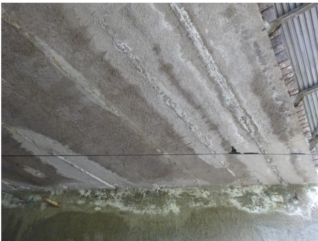
Obr. 1.7: Podhled NK a úložný práh opěry O2, povrch překryt stříkanou cementovou omítkou, stopy po zatékání mezi nosníky, vápenné výluhy
