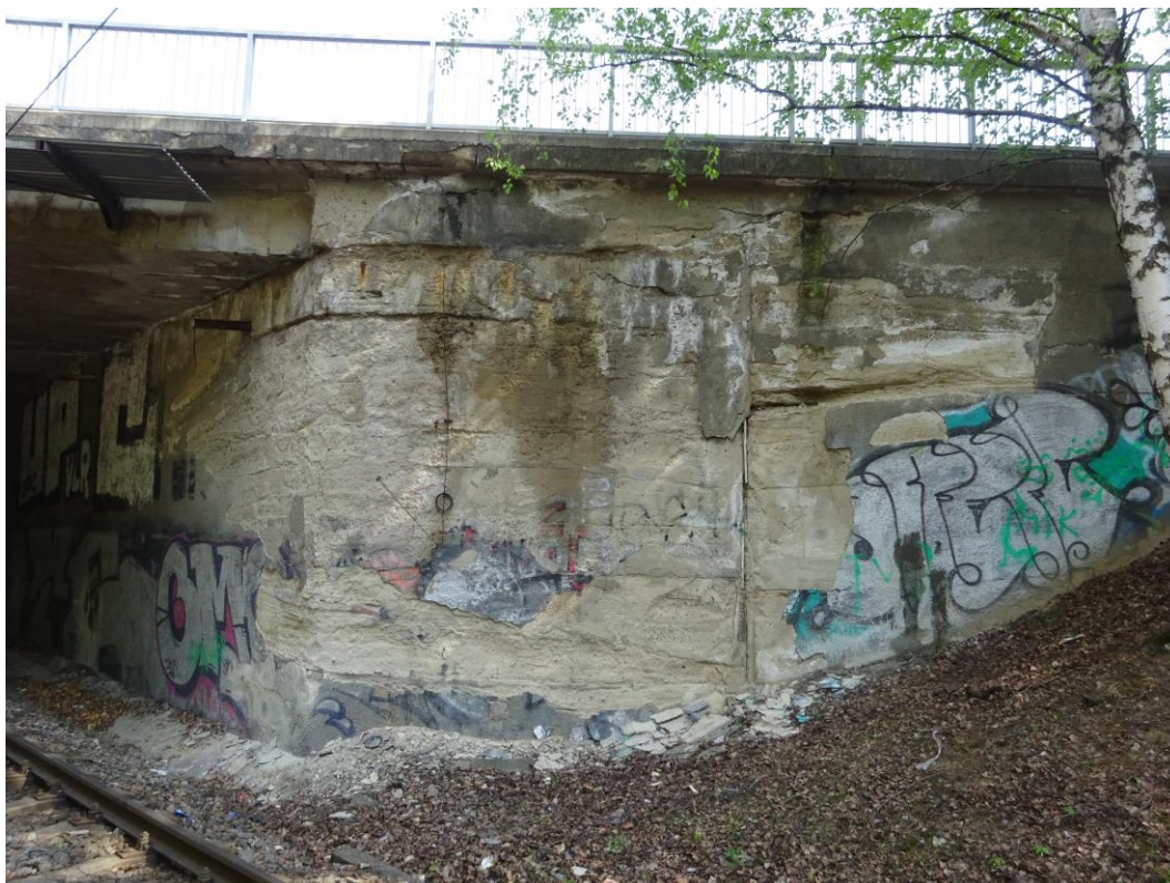
Obr. 1.8: Opěra O2 zprava a křídlo O2P, omítka opadaná, rozpad povrchové vrstvy
