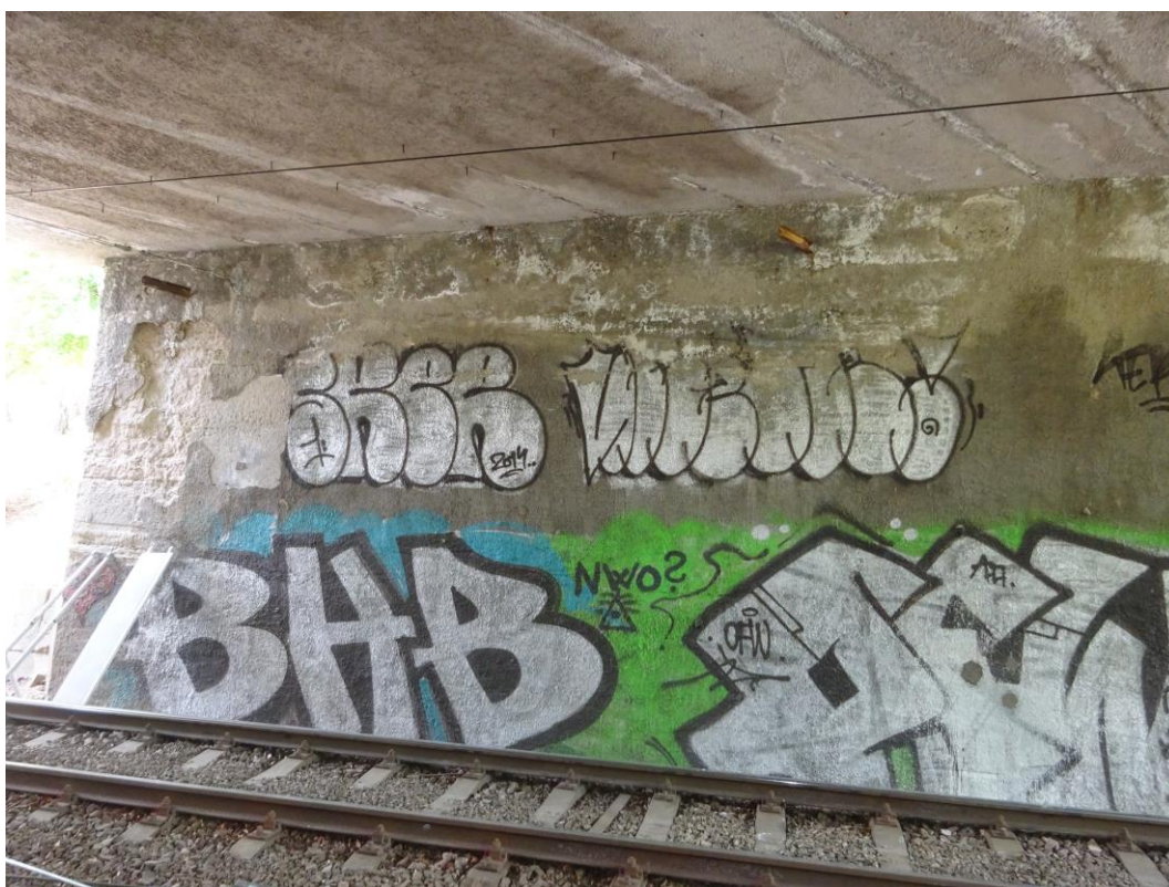
Obr. 1.5: Opěra O1 a podhled NK – stopy zatékání, výluhy, výkvěty, lokální rozpad povrchové vrstvy betonu opěry, opěra pokreslena graffiti.
