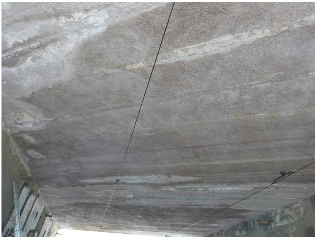
Obr. 1.6: Podhled NK, povrch překryt stříkanou cementovou omítkou, stopy po zatékání mezi nosníky, vápenné výluhy
